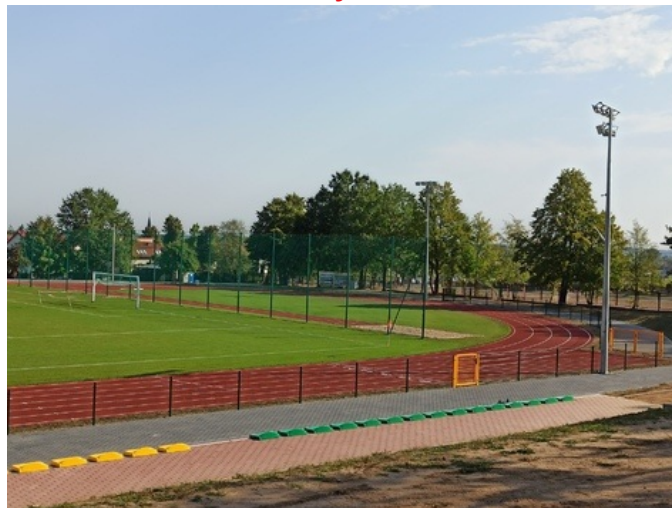
Przebudowa stadionu w Jednoróżcu
